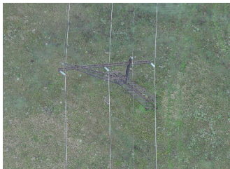
(a) Опора ВЛ-220
